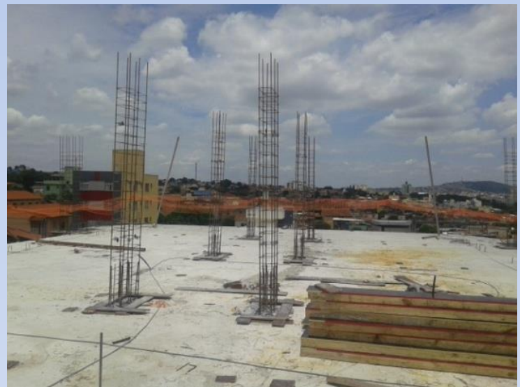
Armação dos pilares N:+20,93
