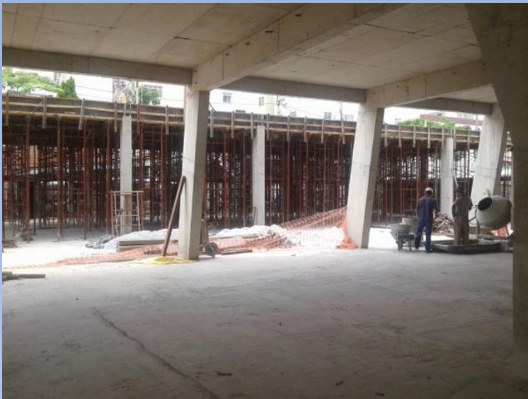
Laje estac. superior concretada
