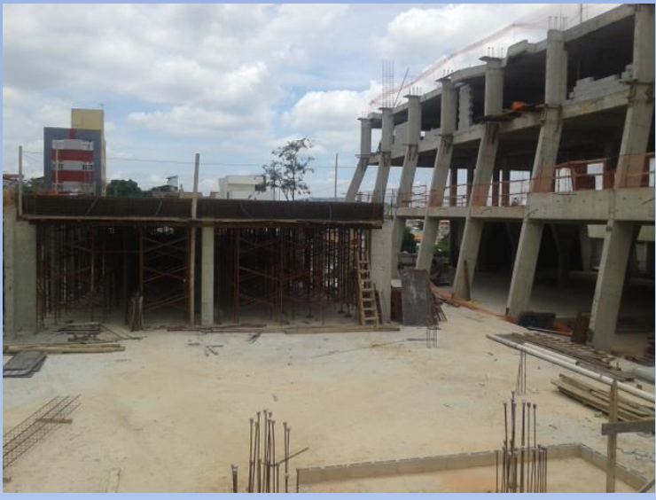
Laje estac. superior concretada
