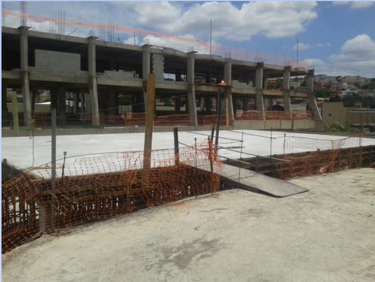
Laje estac. superior concretada
