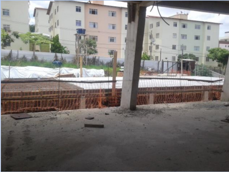
Laje estac. superior concretada
