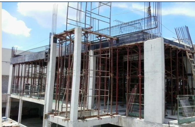
MONTAGEM DAS FORMAS DA 4ª LAJE DO HOTEL
