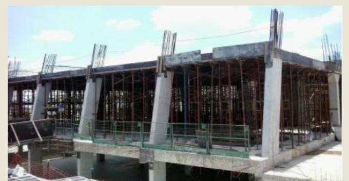
MONTAGEM DAS FORMAS DA 4ª LAJE DO HOTEL
