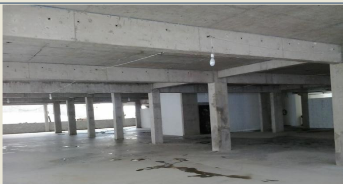
GARAGEM NÍVEL 5,50 DO HOTEL
