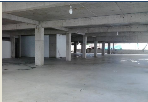
GARAGEM NÍVEL 5,50 DO HOTEL
