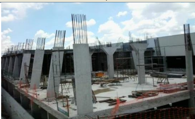
MONTAGEM DAS FORMAS DA 4ª LAJE DO HOTEL
