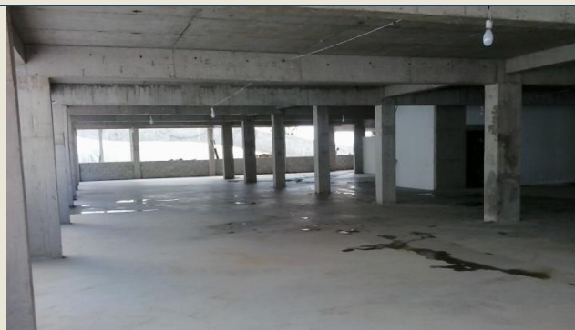
GARAGEM NÍVEL 5,50 DO HOTEL
