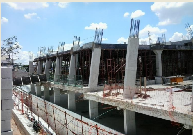
MONTAGEM DAS FORMAS DA 4ª LAJE DO HOTEL
