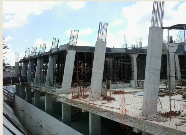
MONTAGEM DAS FORMAS DA 4ª LAJE DO HOTEL
