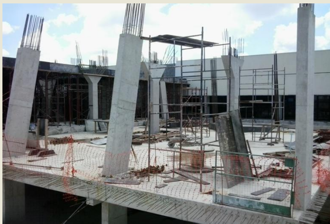
MONTAGEM DAS FORMAS DA 4ª LAJE DO HOTEL
