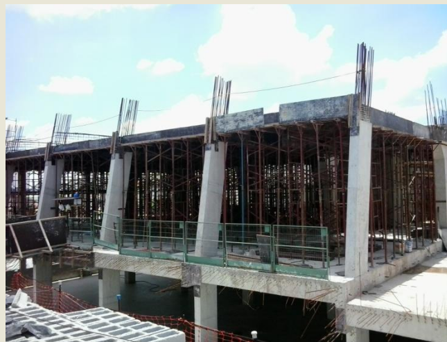
MONTAGEM DAS FORMAS DA 4ª LAJE DO HOTEL
