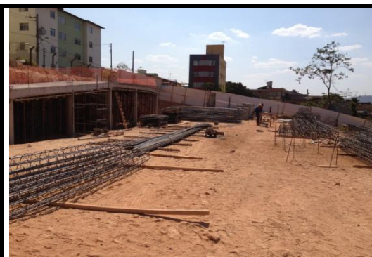
Armação Tubulões
