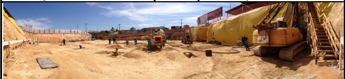
Escavação dos Blocos/Cinta Prédio 1
