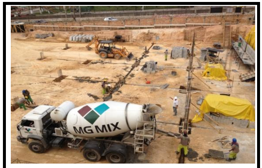
Concretagem de cintamento Prédio 1
