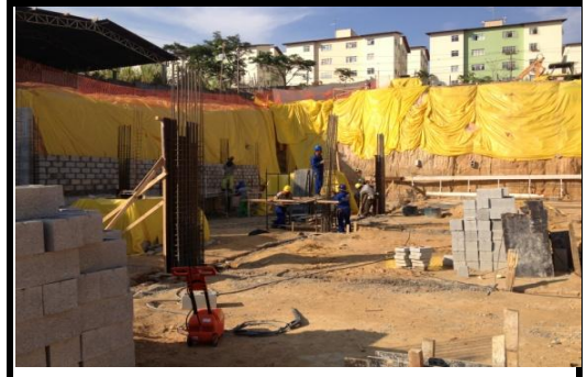
Armação/Fôrma Pilares Prédio 1
