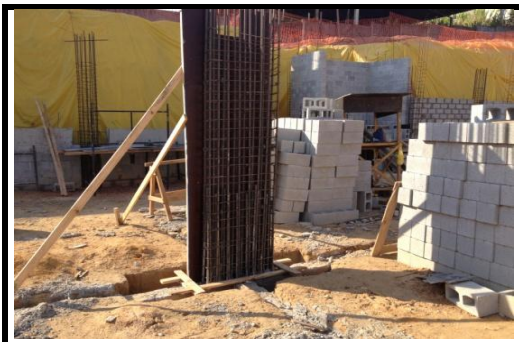
Armação/Fôrma Pilares Prédio 1
