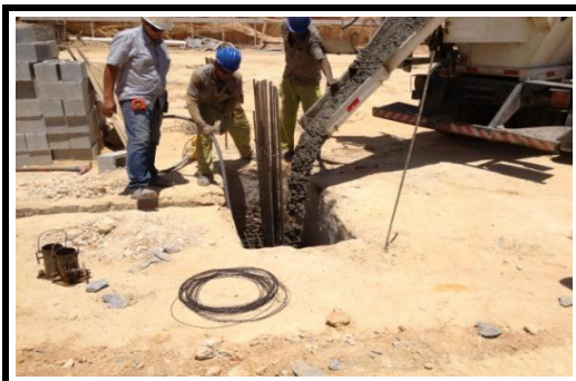
Concretagem de Blocos - Prédio 1
