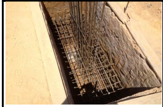
Blocos Fundação Prédio 1
