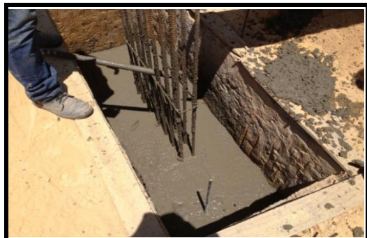
Concretagem de Blocos - Prédio 1
