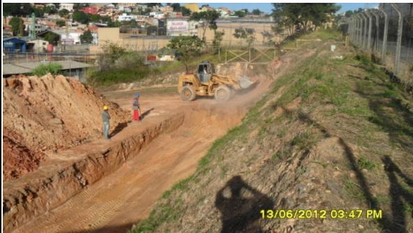
Terraplenagem 1ª Fase
