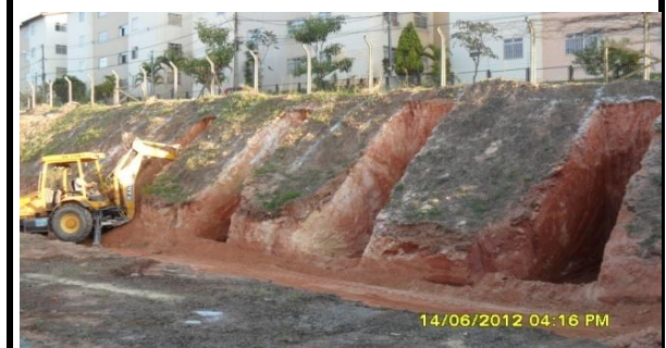
Abertura das Valas p/ Bloco Fundação
